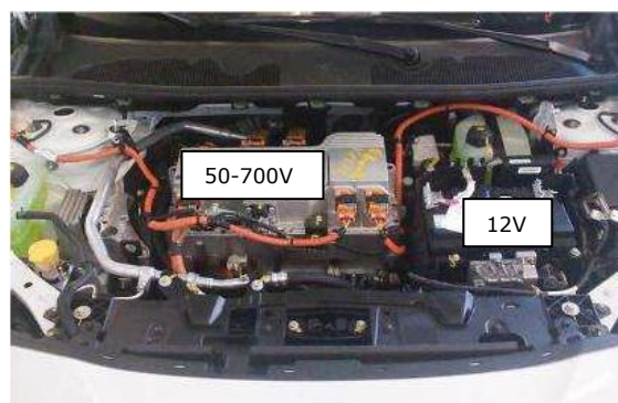
Motorrum på et elkøretøj. De kraftige, strømførende orange ledninger og 12 volt batteriet til højre.
